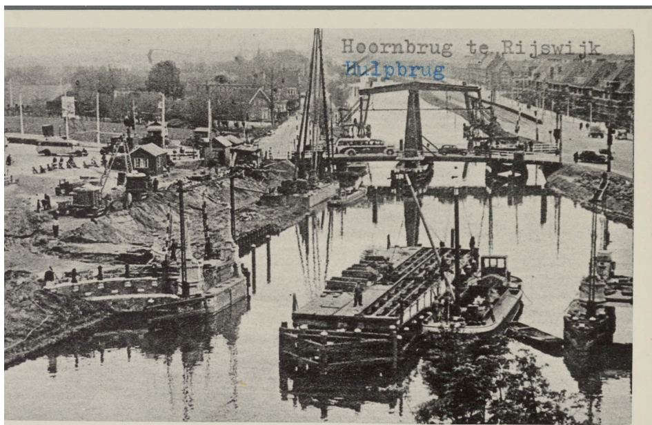
Afbeelding 20. De sloop van de brug uit 1891 op een foto uit ca. 1937. Op de achtergrond de tijdelijke hulpbrug. Herkomst afbeelding: www.beeldbankrijswijk.nl
